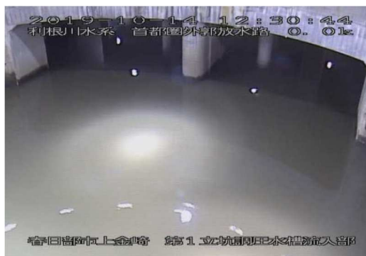
第1立坑から調圧水槽への流入状況
