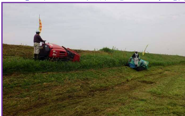
堤防除草作業の状況
