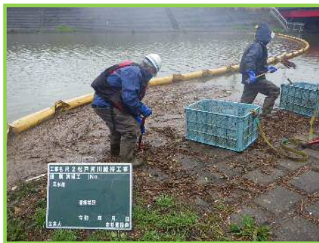
坂川放水路清掃状況
