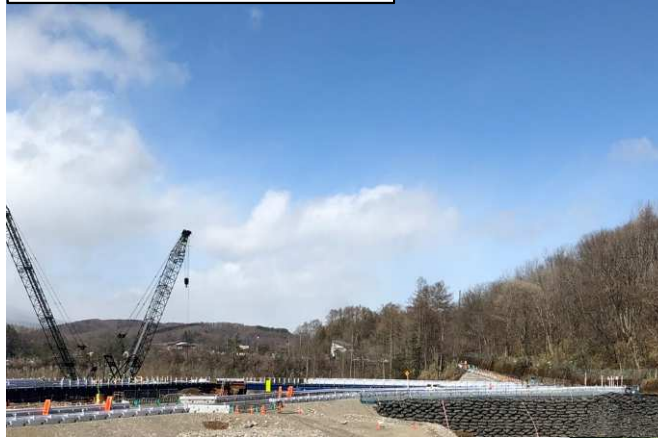
写真② 仮橋施工状況
