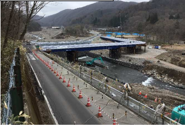
写真① 渡河部仮橋状況
