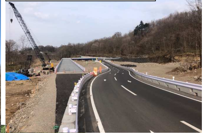
写真③ 終点側仮橋施工状況
