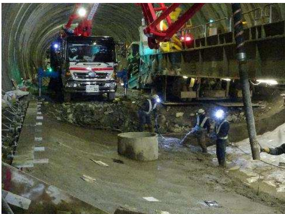
— 新三国トンネルの施工状況 —
