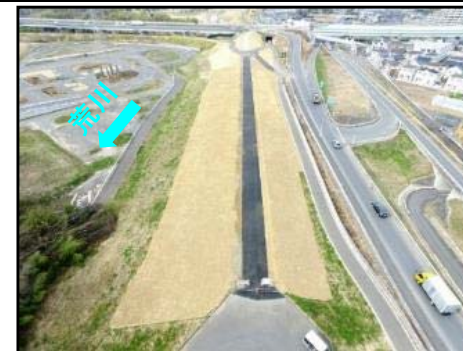
荒川 堤防整備事例(さいたま築堤)
