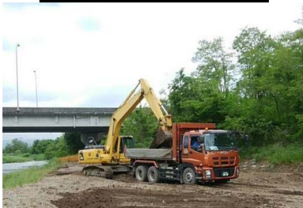
河道内の土砂掘削事例
