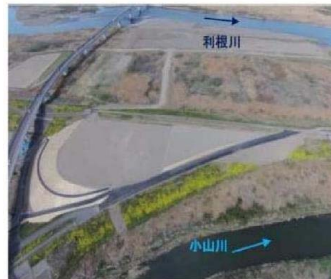
下高島地区(埼玉県深谷市)
