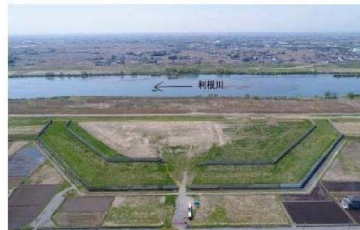
栄地区広域避難地(埼玉県加須市)
