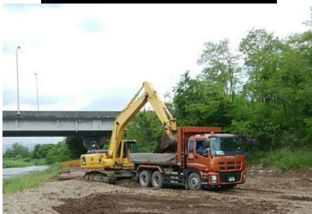
河道内の土砂掘削事例
