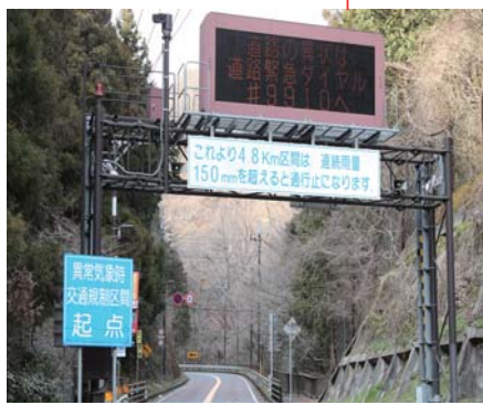
通行規制が行なわれる際、閉められるゲート(大垂水区間)
