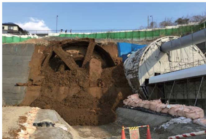
(仮称)館第一トンネル 上り線側貫通状況
