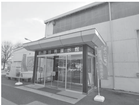
写真—1 建設技術展示館
