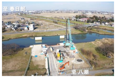
② 東埼玉道路(延伸)の工事状況
