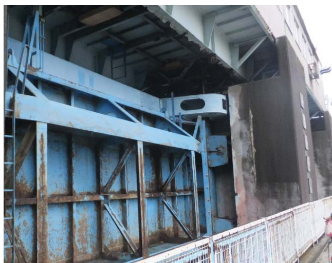
水門の老朽化状況
