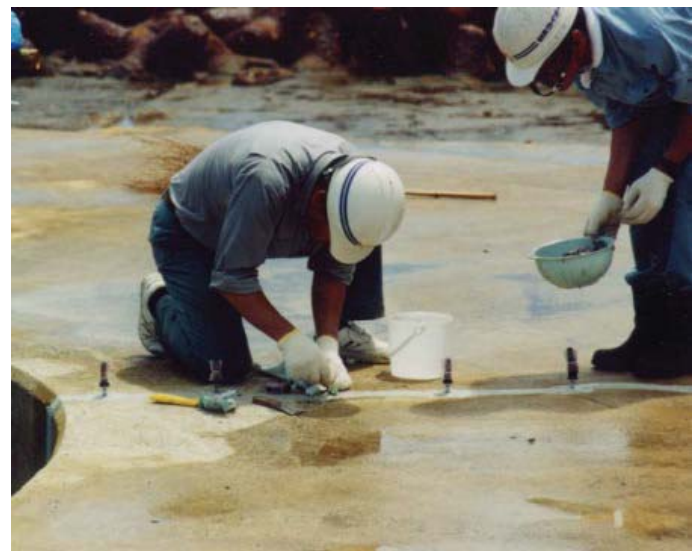
コンクリート護岸ひび割れ補修
