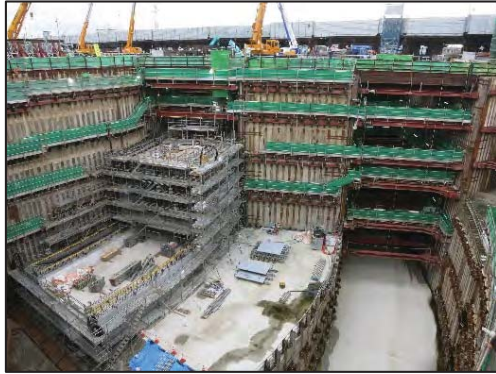
中央JCT開削工事の状況
