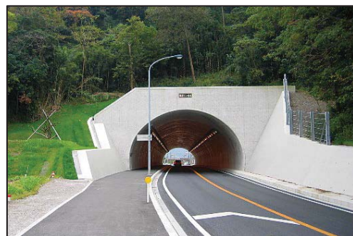
勝岩トンネル(対策済) (トンネル拡幅実施)
