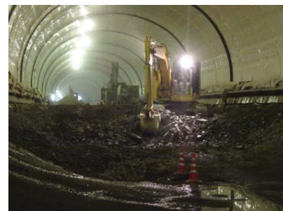
新三国トンネル 施工状況
