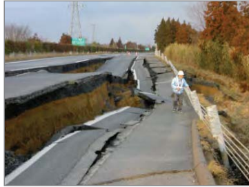
崩落した常磐自動車道 水戸IC～那珂IC付近 出典:東日本高速道路(株)
