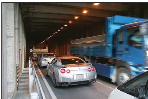
南無谷トンネル (幅員が狭く老朽化が著しいトンネル)
