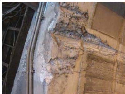
大型車による覆工の擦り状況
