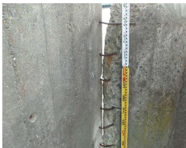
護岸等の老朽化状況
