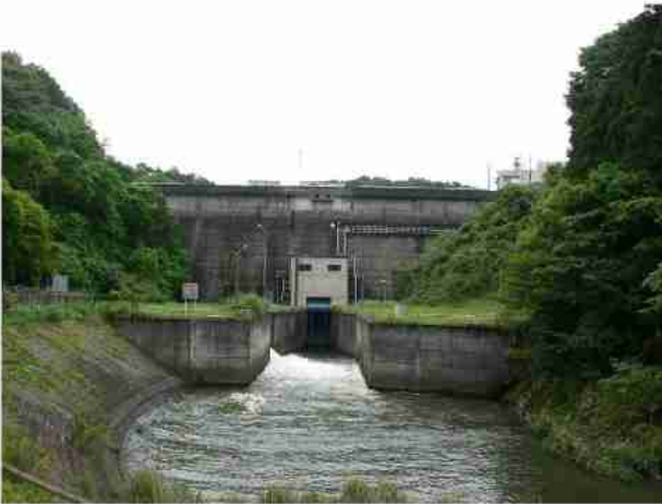
写真1-3 藤井川ダムの状況
