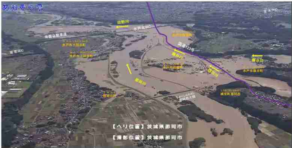
写真 1-3 令和元年東日本台風時の浸水状況（国交省ヘリ撮影）
