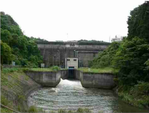
写真1-4 藤井川ダムの状況
