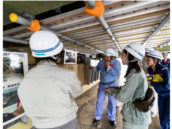
支承部について説明をする関東道路メンテナンスセンター職員
