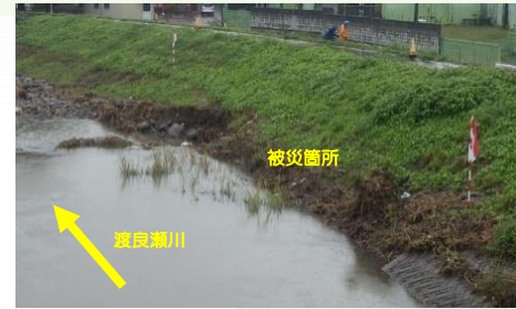
足利市 河川災害復旧工事 写真3
