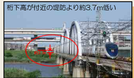
▲京成本線荒川橋梁
