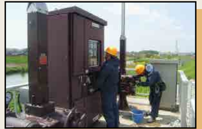
▲河川管理施設の点検状況
