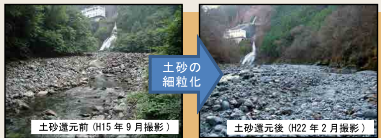
▲ダム貯水池に堆積した土砂還元前後の下流河川の様子
