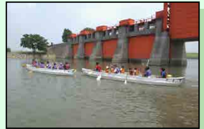
▲歴史的な施設(旧岩淵水門)
