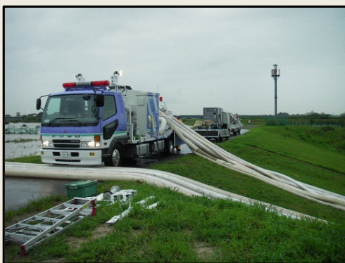
▲災害時の排水ポンプ車出動状況
