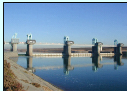
▲秋ヶ瀬取水堰(昭和40年完成)
