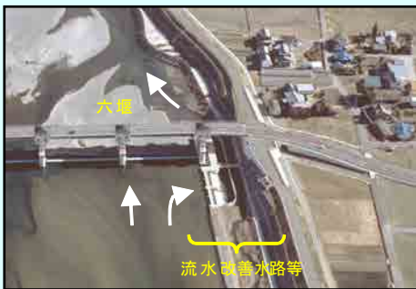
▲流水改善水路
