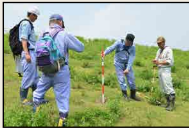
▲堤防点検状況
