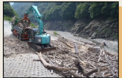
▲流木処理の状況
