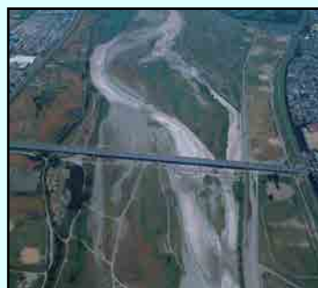
▲荒川大橋付近の瀬切(平成 4 年)
