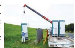
▲簡易トイレの撤去作業
