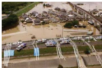
▲排水ポンプ車で素早く排水します
