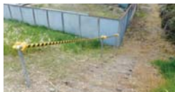
▲危険箇所の修復
