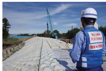
▲被災現場の復旧状況の監督
