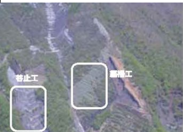
編柵工法 攔砂壩
