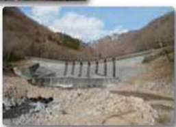
15 稲荷川第10上流砂防堰堤
