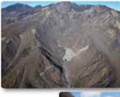
14 日向砂防堰堤
