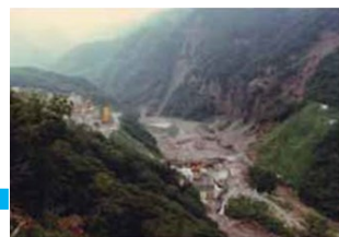
第2次加高工程施工中 （1978年拍摄）
