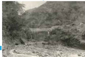
第1次加高工程施工后 （1953年拍摄）
