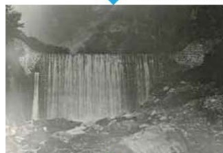
施工後 昭和4年撮影
