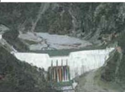
第2次加高工程施工后 （1982年拍摄）
