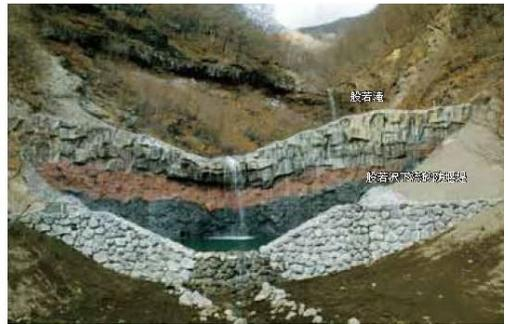
般若泽下游防沙堰堤是从目前的岩石取型，制作“拟岩模框”，浇筑混凝土后，在表面进行着色。在让其自然地融入景观方面做出了各种努力。
