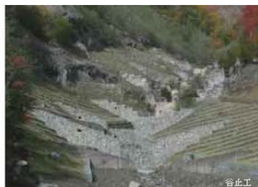
“谷止工（山谷河岸稳固工程）”
