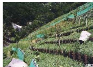
“编柵工（打桩编柵工程）”
