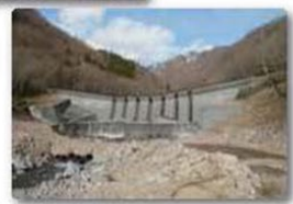
15 稲荷川第10 上流砂防堰堤
