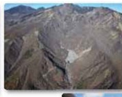
14 日向砂防 堰堤
