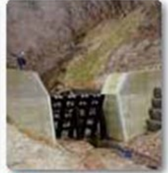
10 田茂沢第2 砂防堰堤
