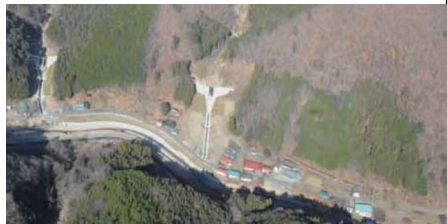
Dique de contención construido tras el desastre
