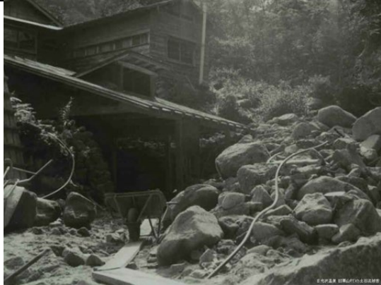
Daños producidos por flujos de escombros en la aldea Nikkozawa Onsen (la anteriormente llamada Kuriyama)
