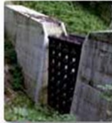
10 田茂沢第1砂防堰堤
