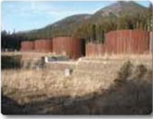
3 久次良地区 (野上沢下流砂防堰堤)
