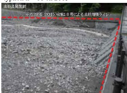
Avant la coulée de débris Ligne de dépôt de débris causés par le typhon n° 18 en 2015
