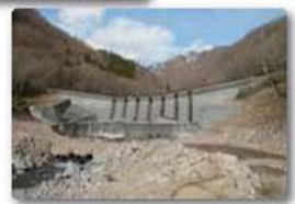
15 稲荷川第10上流砂防堰堤
