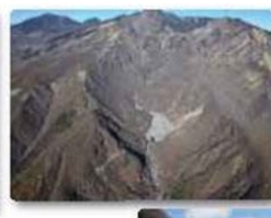
14 日向砂防堰堤
