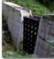
10 田茂沢第1砂防堰堤
