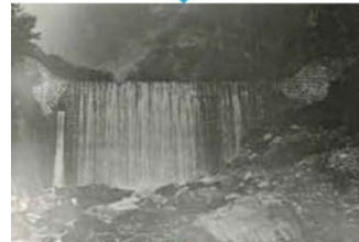
施工後 昭和4年撮影
