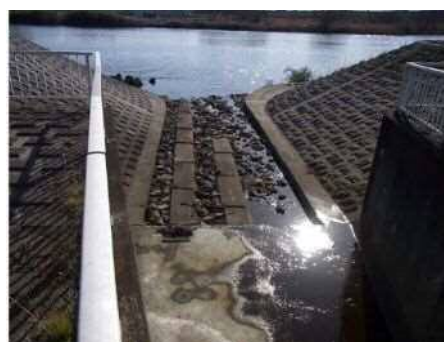
勝倉第六排水樋管の土砂堆積（那珂川）
