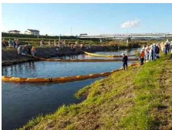
オイルフェンス設置
