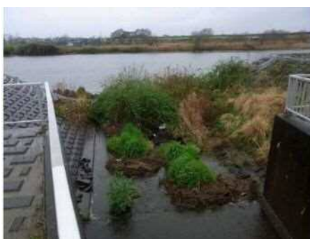
勝倉第六排水樋管の土砂堆積（那珂川）
