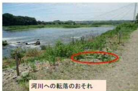
階段護岸の雑草繁茂により転倒の恐れ
