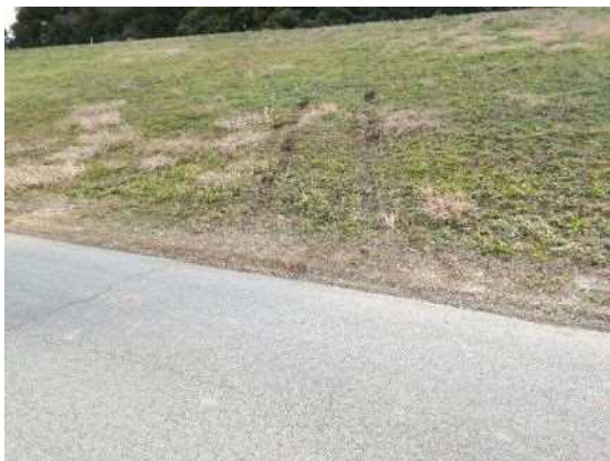
堤防への車両の乗り入れ跡
