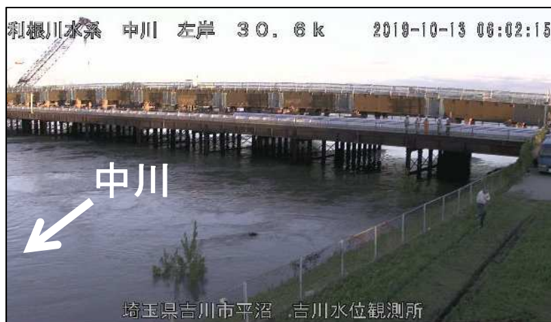
中川出水状況(埼玉県吉川市付近)
