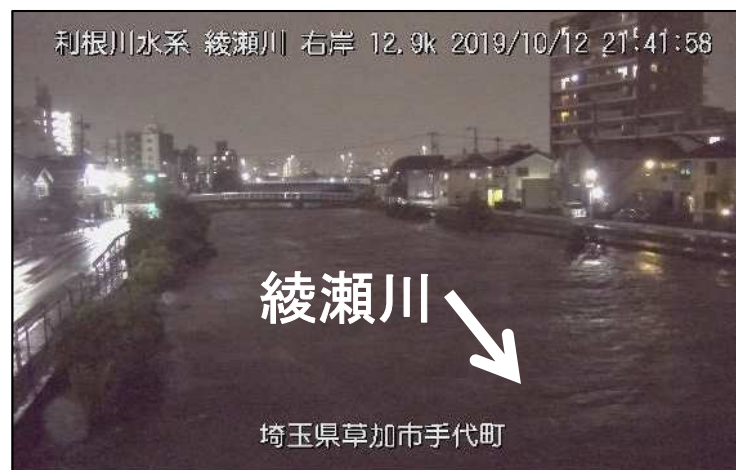
綾瀬川出水状況(埼玉県草加市付近)
