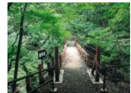
遊歩道(鹿飛橋)
