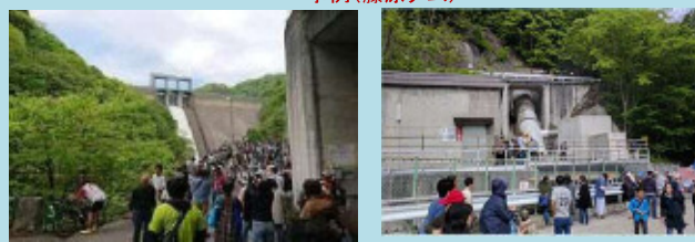
事例(藤原ダム)
