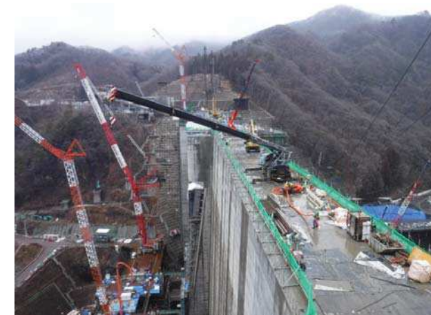
写真 ハツ場ダム (H31.3.7撮影)
