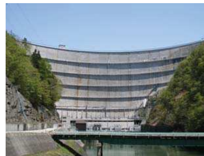
写真 矢木沢ダム
