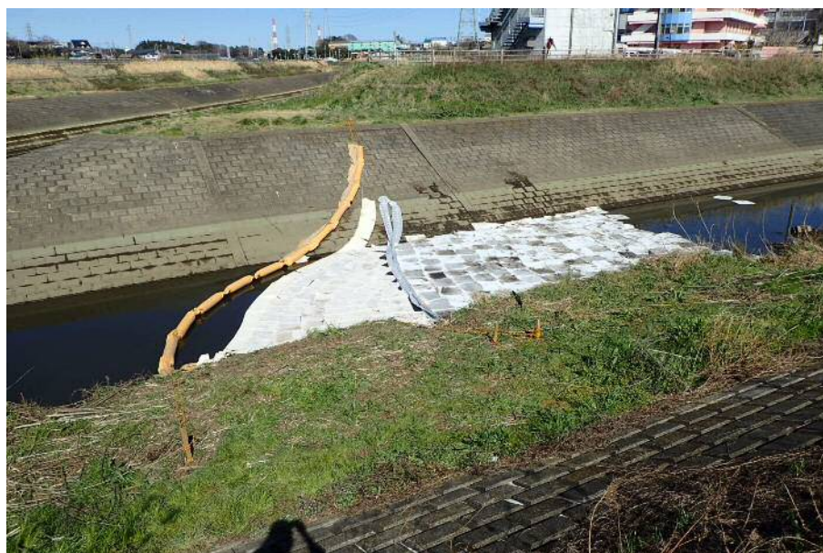
富士川と坂川との合流地点に設置した対策工の様子
