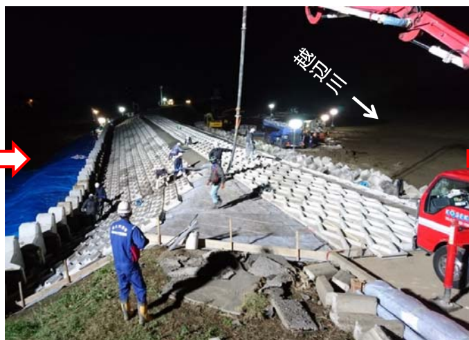
10月24日 19時00分時点 堤防盛土の補強(シート・ブロック張)
