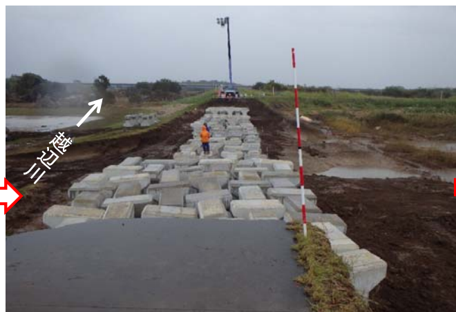
10月17日 8時00分時点 根固めブロック投入
