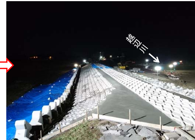
10月24日 20時10分時点 緊急復旧工事完了
