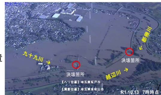
入間川流域における浸水被害状況
