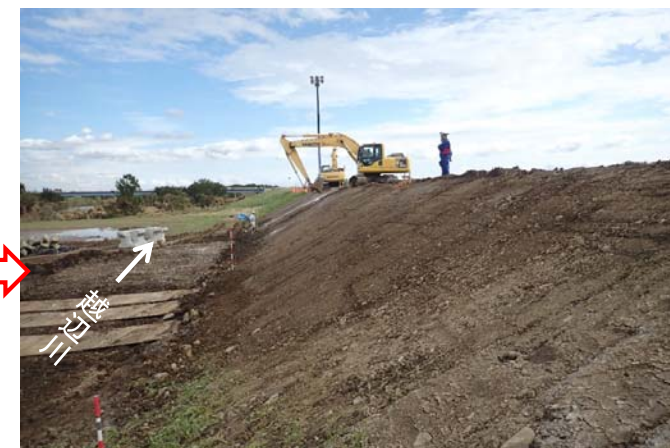
10月20日 11時00分時点 堤防盛土完了
