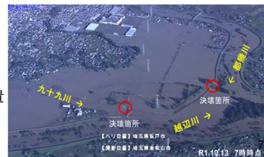
入間川流域における浸水被害状況
