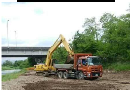
河道内の土砂掘削事例
