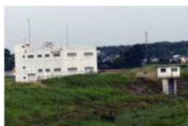
・岡排水機場（東松山市） ・昭和60年設置 （最大排水能力5m 3 /s）
