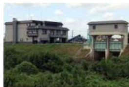
・九十川排水機場（川越市） ・平成15年設置 （最大排水能力20m 3 /s）
