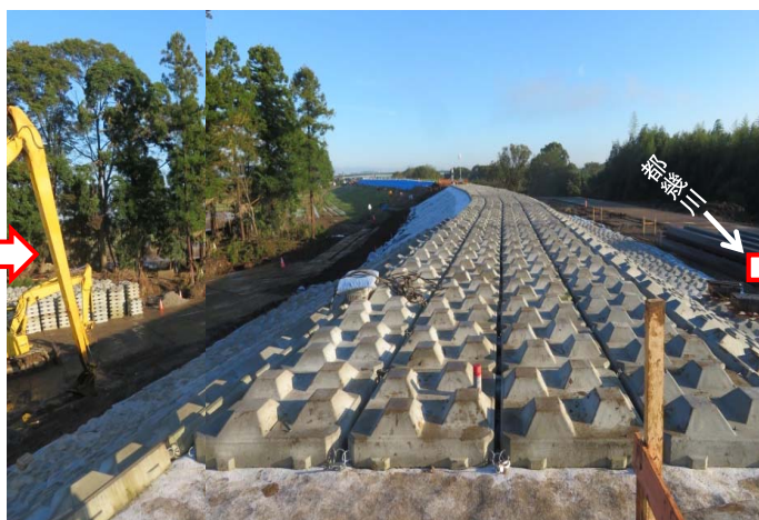
10月23日 8時00分時点 堤防盛土の補強(シート・ブロック張)
