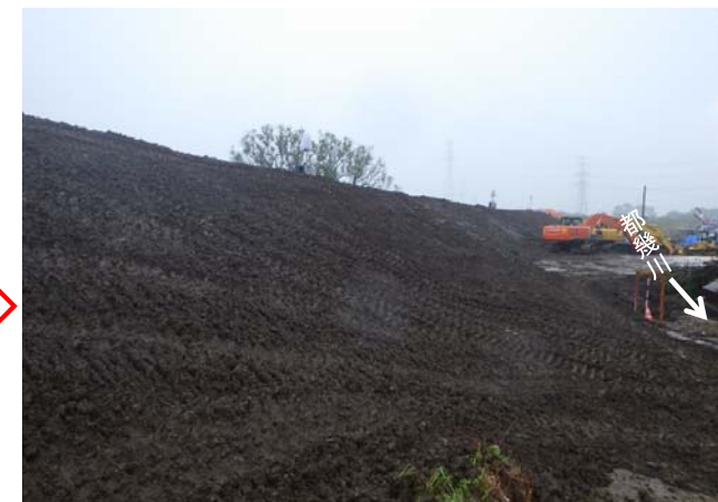
10月19日 6時00分時点 堤防盛土
