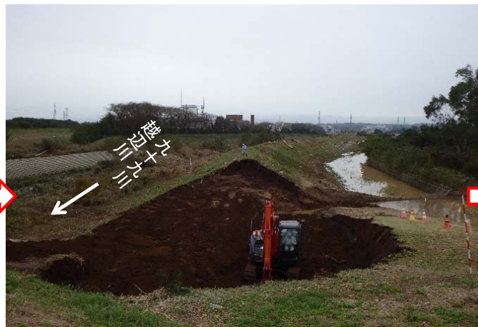
10月14日 11時50分時点 現地整正作業
