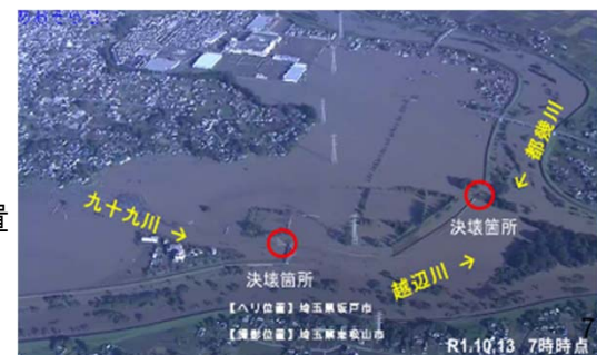
入間川流域における浸水被害状況
