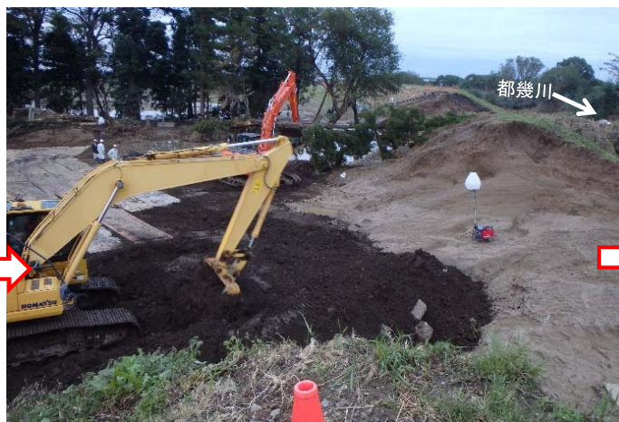
10月16日 8時00分時点 堤防盛土
