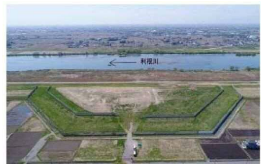
栄地区広域避難地(埼玉県加須市)
