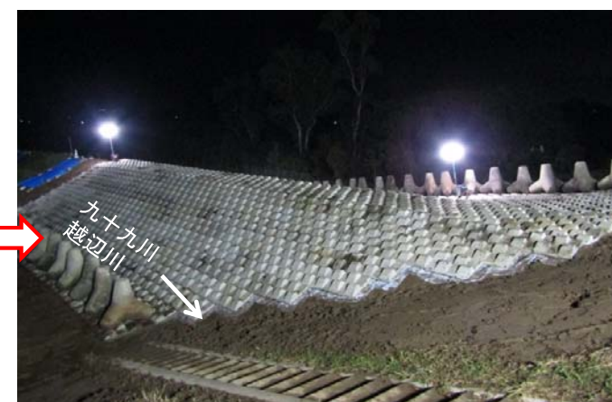
10月19日21時20分時点 緊急復旧工事完了
