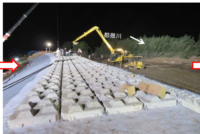
10月21日 19時00分時点 堤防盛土の補強(シート・ブロック張)
