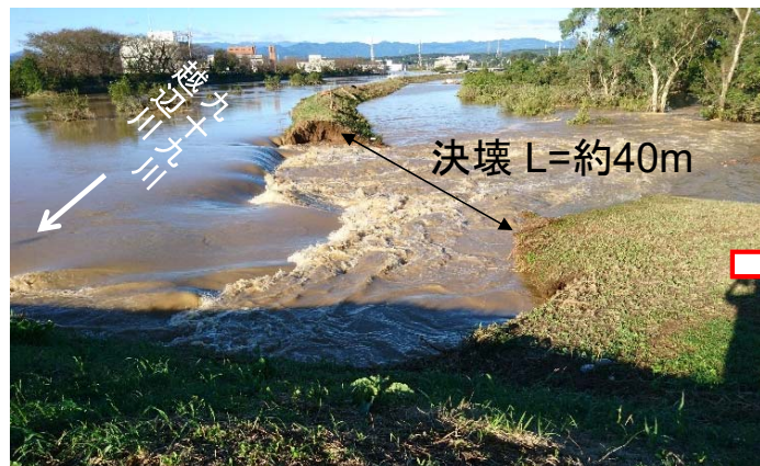
10月13日 7時50分時点 決壊後の状況
