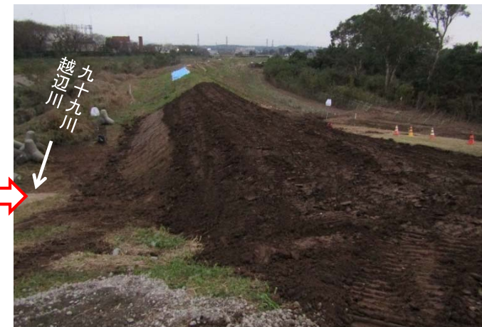
10月17日 8時00分時点 堤防盛土完了
