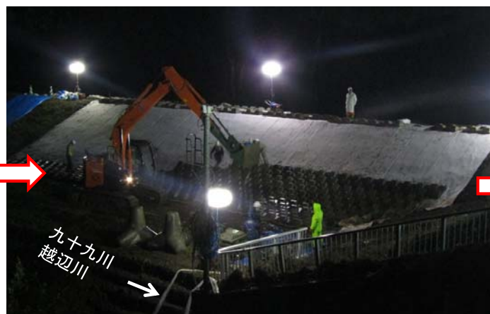
10月18日 21時30分時点 堤防盛土の補強(シート・ブロック張)
