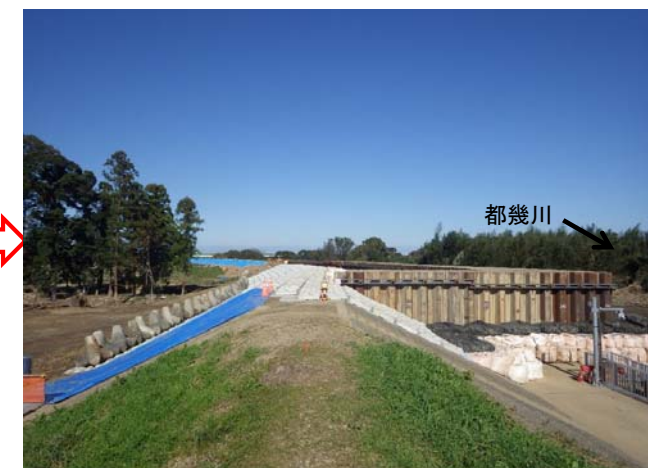
11月8日 13時00分時点 緊急復旧工事完了
