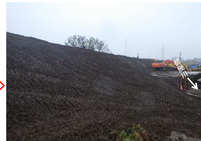
10月19日 6時00分時点 堤防盛土
