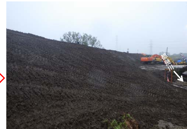
10月19日 6時00分時点 堤防盛土
