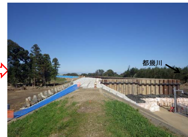
11月8日 13時00分時点 緊急復旧工事完了
