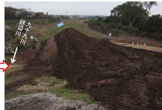
10月17日 8時00分時点 堤防盛土完了
