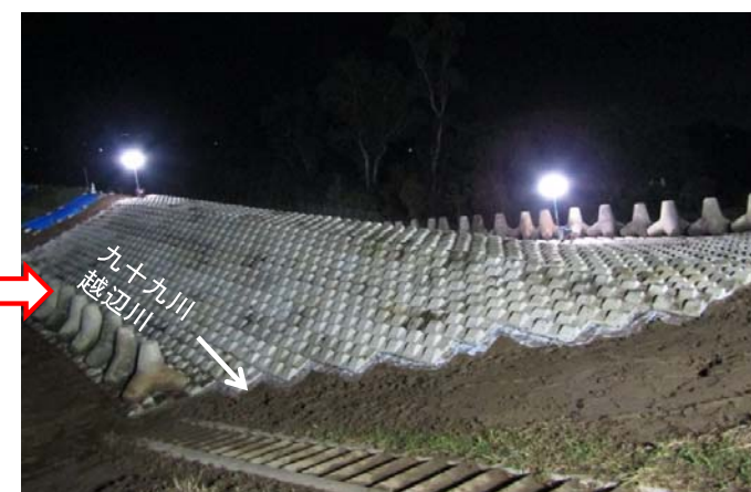
10月19日21時20分時点 緊急復旧工事完了
