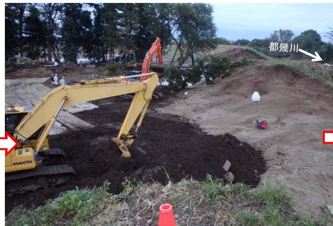
10月16日 8時00分時点 堤防盛土
