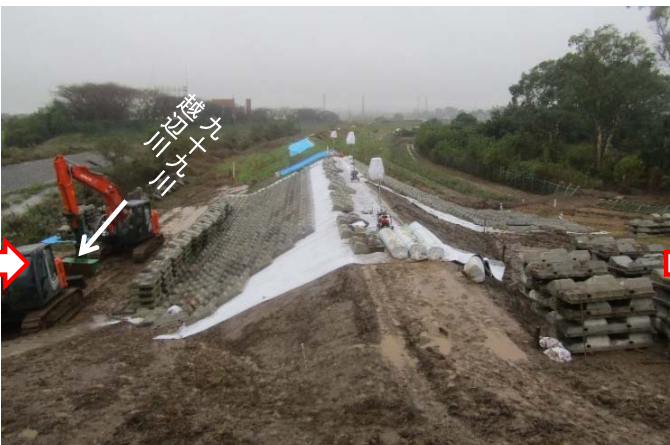
10月19日 8時00分時点 堤防盛土の補強(シート・ブロック張)
