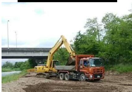
河道内の土砂掘削事例
