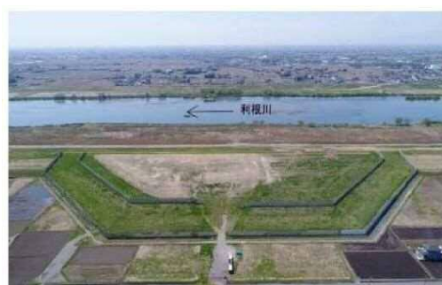
栄地区広域避難地(埼玉県加須市)
