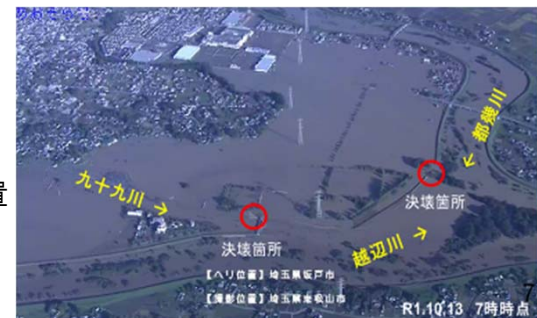
入間川流域における浸水被害状況
