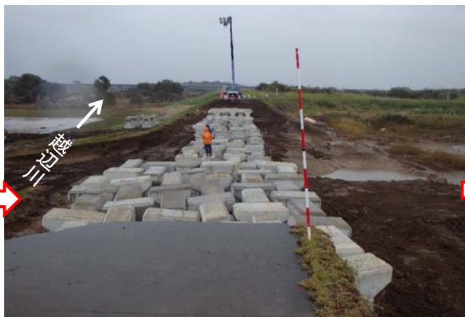
10月17日 8時00分時点 根固めブロック投入
