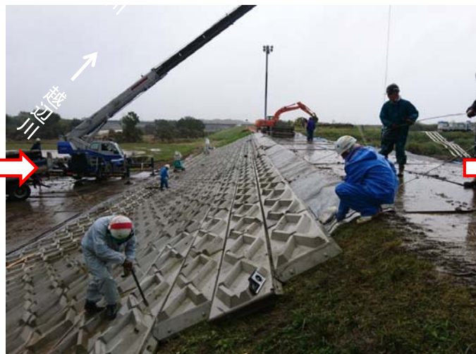
10月22日 11時00分時点 堤防盛土の補強(シート・ブロック張)
