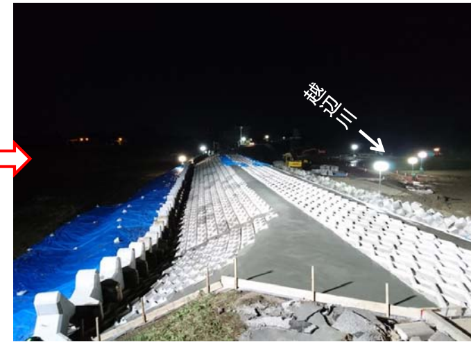
10月24日 20時10分時点 緊急復旧工事完了
