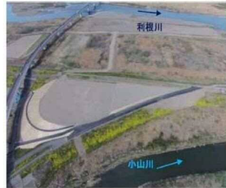
下高島地区(埼玉県深谷市)
