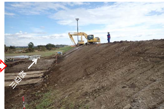
10月20日 11時00分時点 堤防盛土完了
