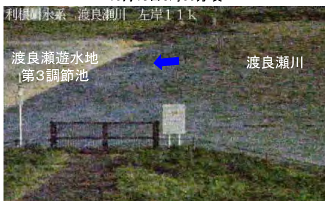
渡良瀬遊水地 第3越流堤 10月13日2時40分頃
