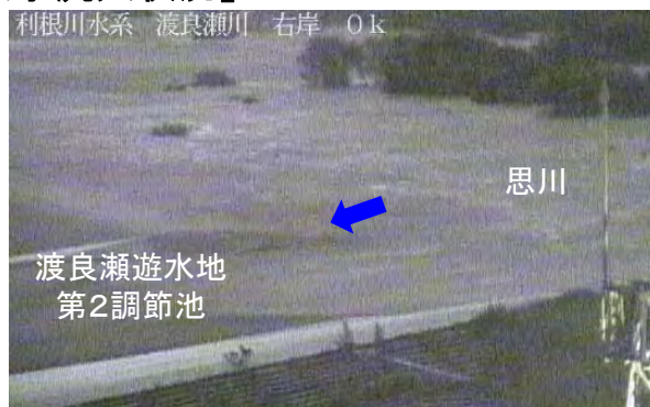
渡良瀬遊水地 第2越流堤 10月12日23時10分頃
