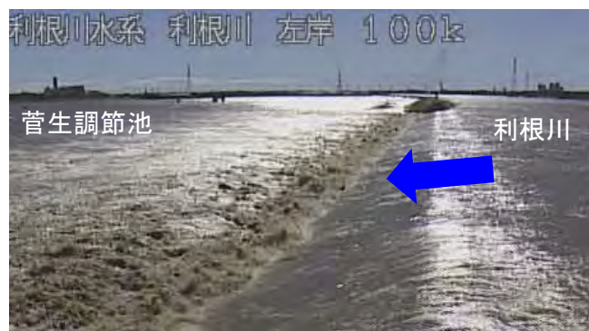
菅生調節池 越流堤 10月13日10時頃
