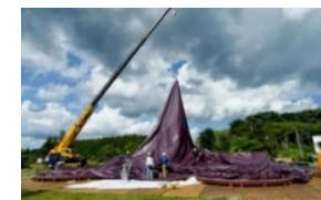
設置中の様子
