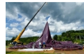
設置中の様子
