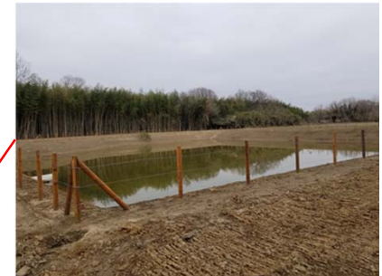
2019下池掘削箇所
