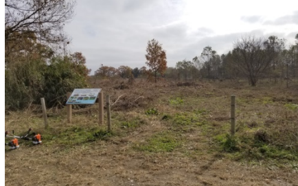
作業後(看板付近)
