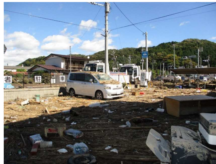
大子町役場浸水被害
