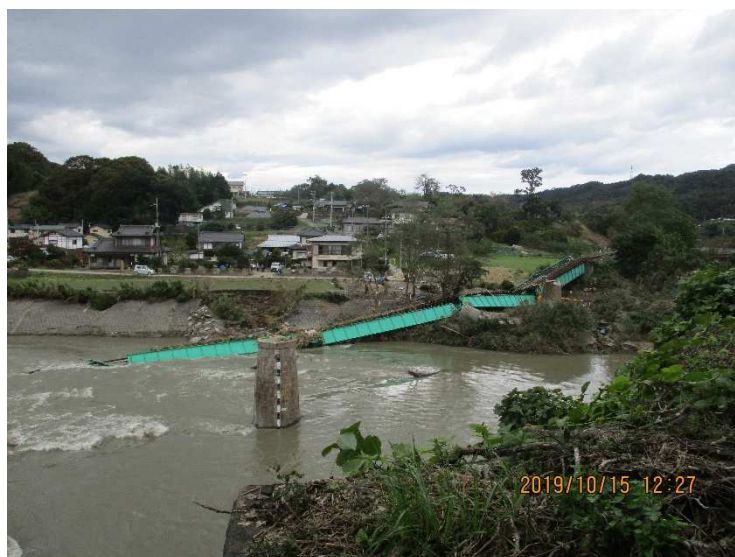
水郡線落橋(大子町袋田地内)
