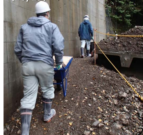
人力による生石灰の搬入作業 (10/19)
