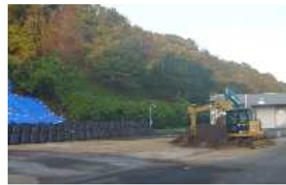
<応急措置工事の状況>
