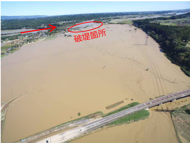
那珂川氾濫の様子
