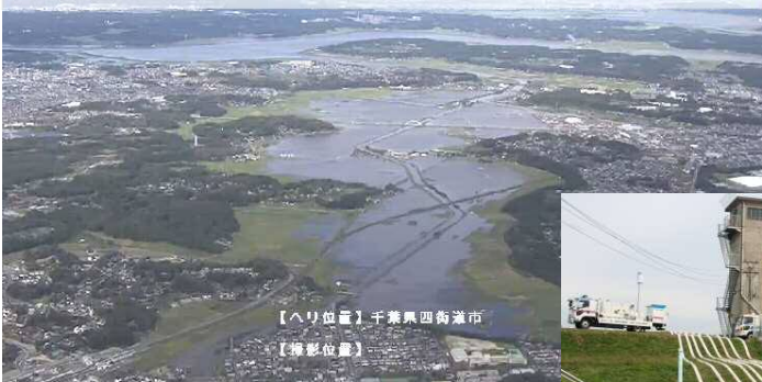
千葉県佐倉市（印旛沼）付近浸水状況(10/26)
