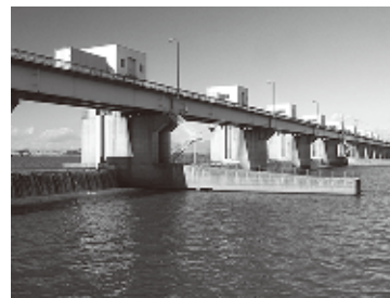
利根川にある利根大堰。取水した水は武蔵水路によって荒川へ導水されます
