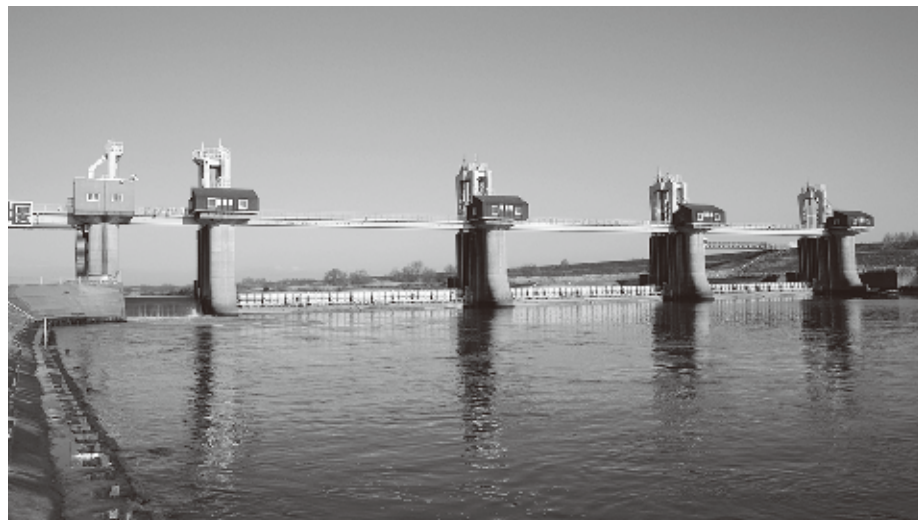
荒川にある秋ヶ瀬取水堰。ここで取水された水は、埼玉・東京の約1680万人の飲み水になります
