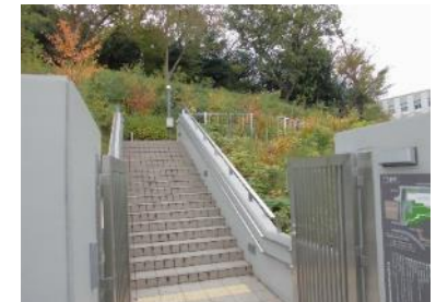
③遊歩道入口(上中里駅側)
