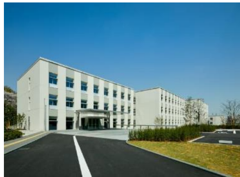
正面全景写真
