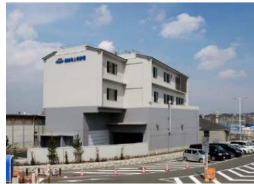
正面全景写真
